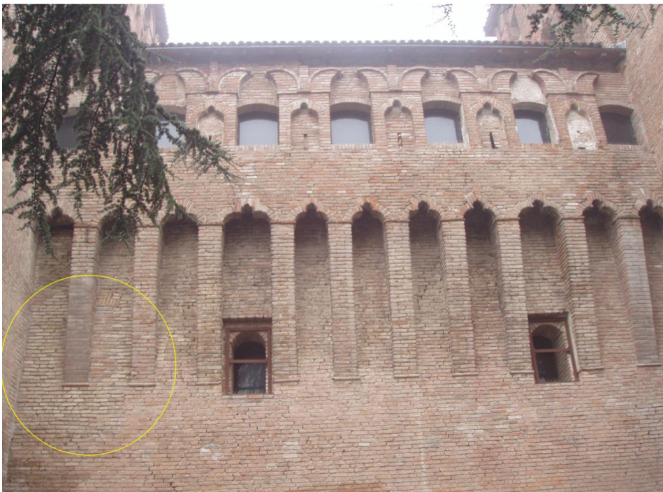
Fig. 19 – Particolare dei merli e dei beccatelli e dell'apertura tamponata sotto il beccatello a sinistra.
