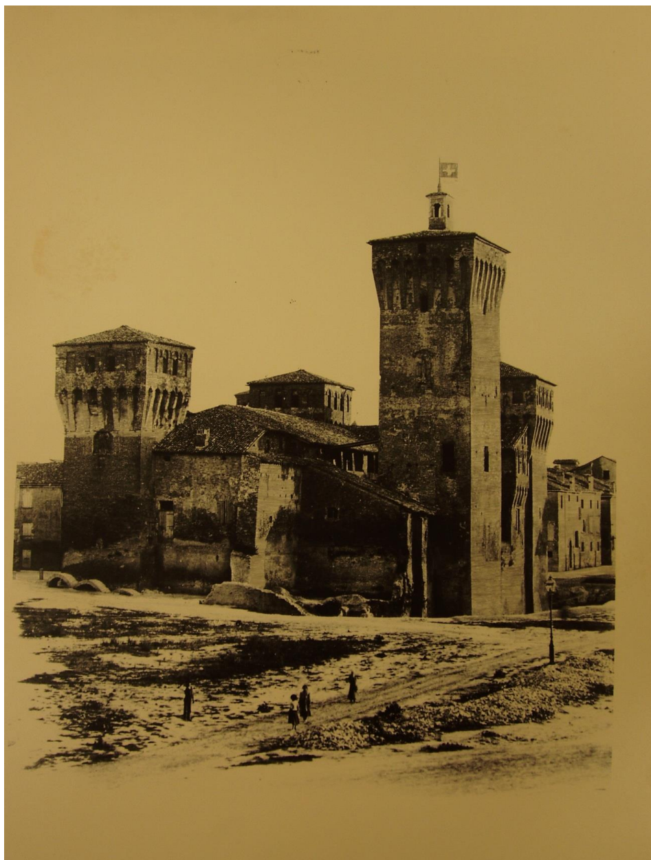
Fig. 33 – Foto Magni, prospetto est con edificio addossato al Mastio.
