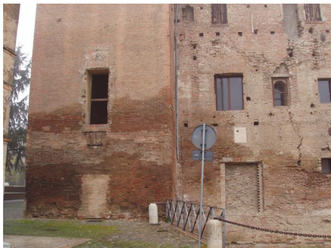
Fig. 23 – Particolare della zona inferiore della torre sud – ovest.
