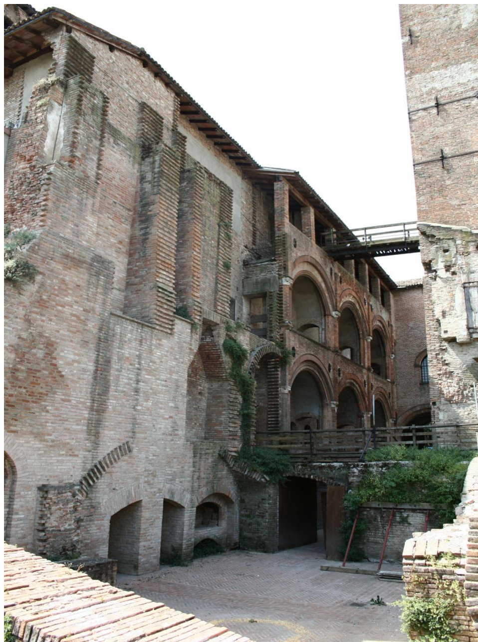
Fig. 14 – Zona restaurata, nella parte occidentale del prospetto nord.
