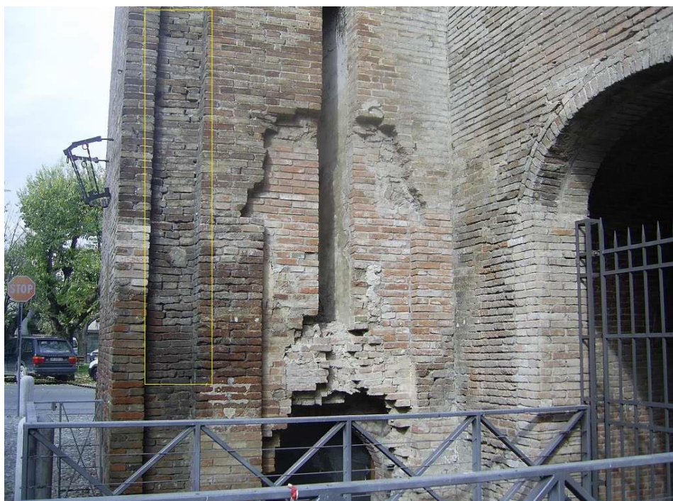
Fig. 15 – Particolare dello “ scasso “ e del ponte levatoio.
