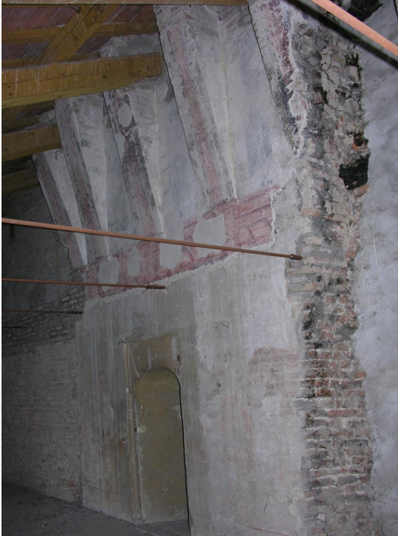
Fig. 39 - Parte della torre nord – ovest e dei suoi beccatelli che sono stati inglobati nella corte marchionale quando Giovanni da Siena ampliò gli spazi abitabili.
