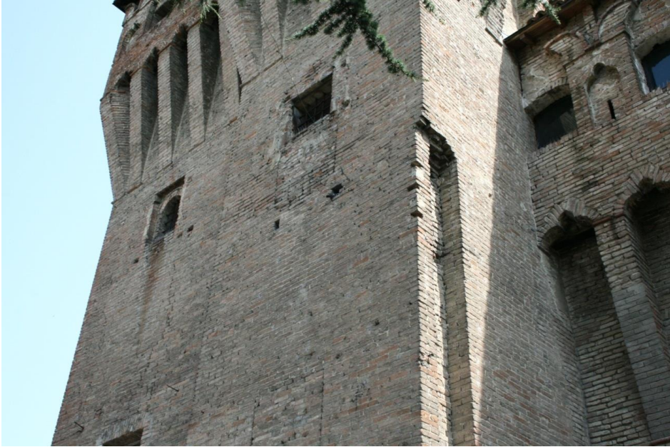
Fig. 16 – Particolare dello “ scasso “ ( USM 439b ) nella parte alta della torre.
