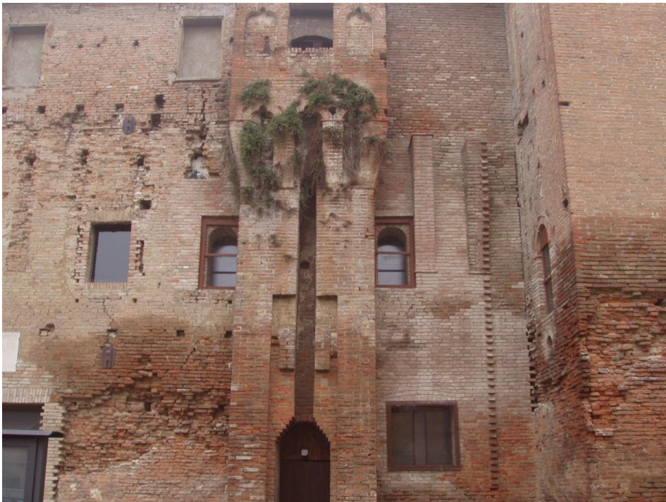
Fig. 26 – Particolare del rivellino e della zona in cui si è intervenuto con il restauro.
