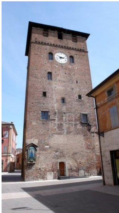
Fig. - 45 Torre dei Modenesi.
