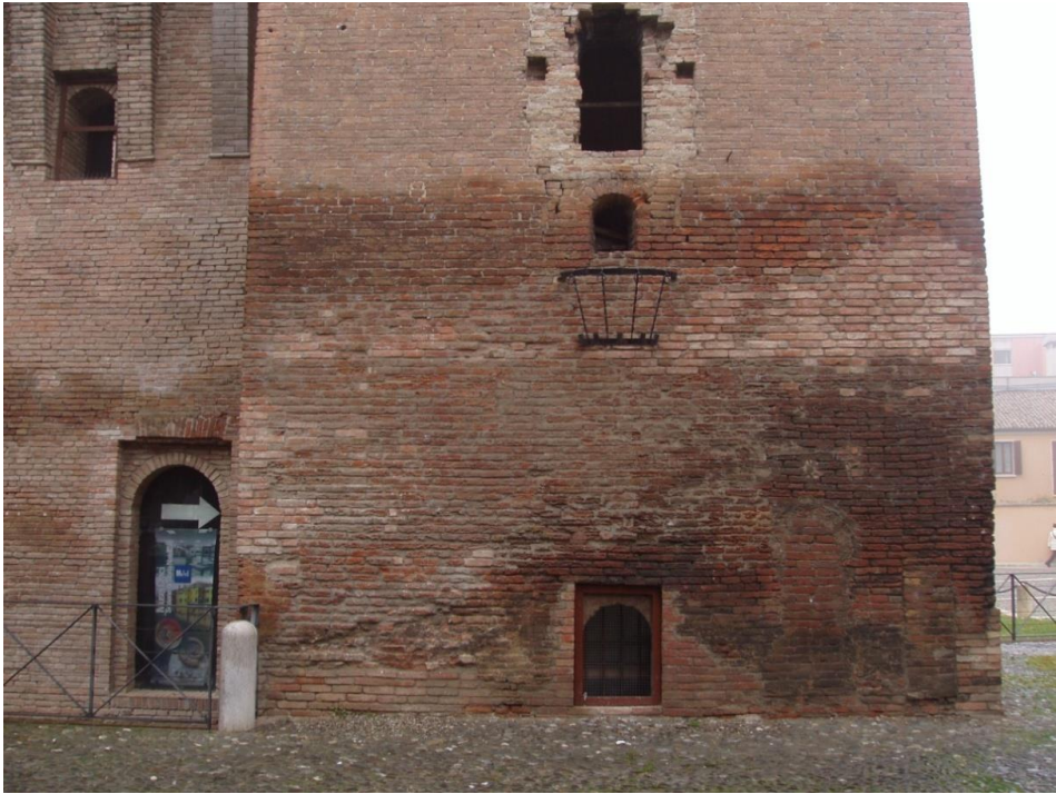
Fig. 22 – Parte inferiore della torre sud – ovest.
