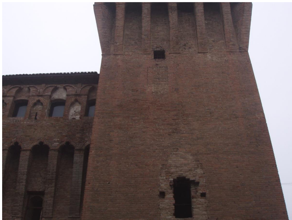
Fig. 21 – Parte terminale della torre sud – ovest.
