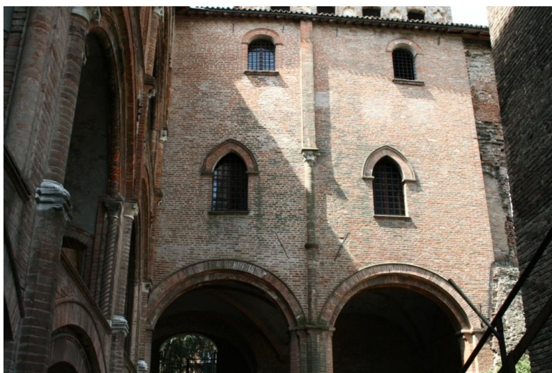
Fig. 10 – Corte interna lato Ovest.
