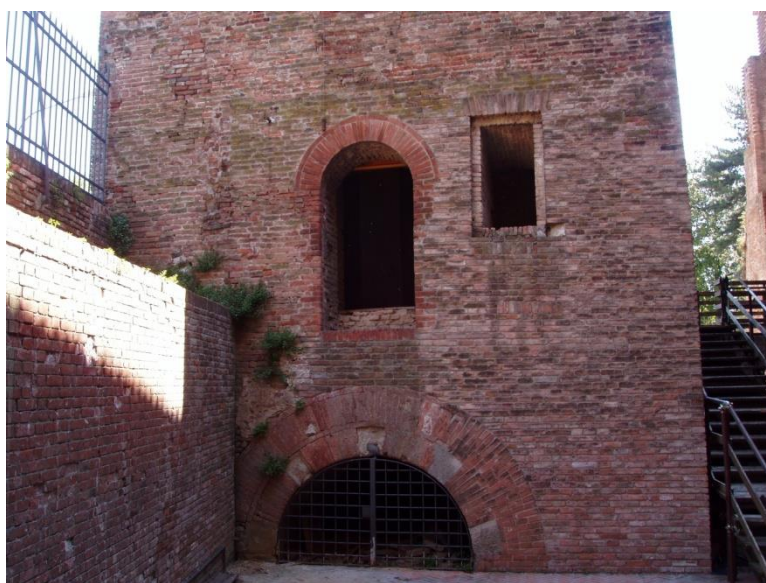
Fig. 7 – Lato Nord – Ovest del Mastio dove è visibile l'antica porta di accesso.
