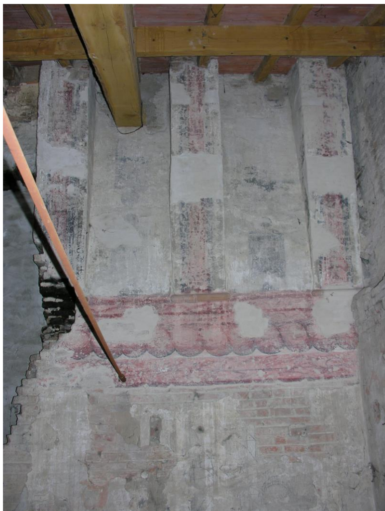
Fig. 40 – Particolare dei beccatelli dipinti che si trovano sulla torre marchesana e visibili dal piano nobile.
