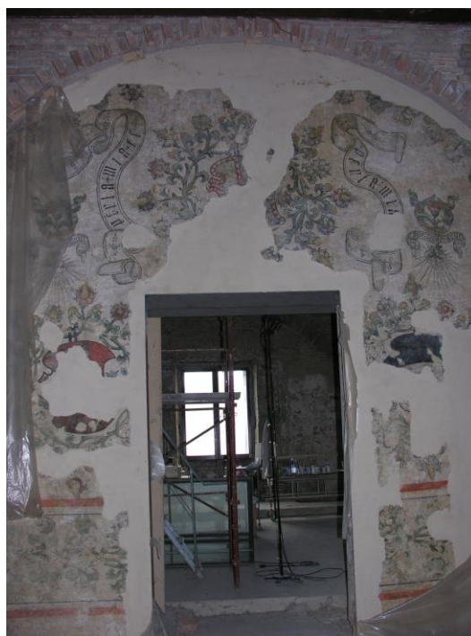
Fig. 43 – Passaggio dalla corte marchionale all'ala sud. Parete affrescata, da poco restaurata.
