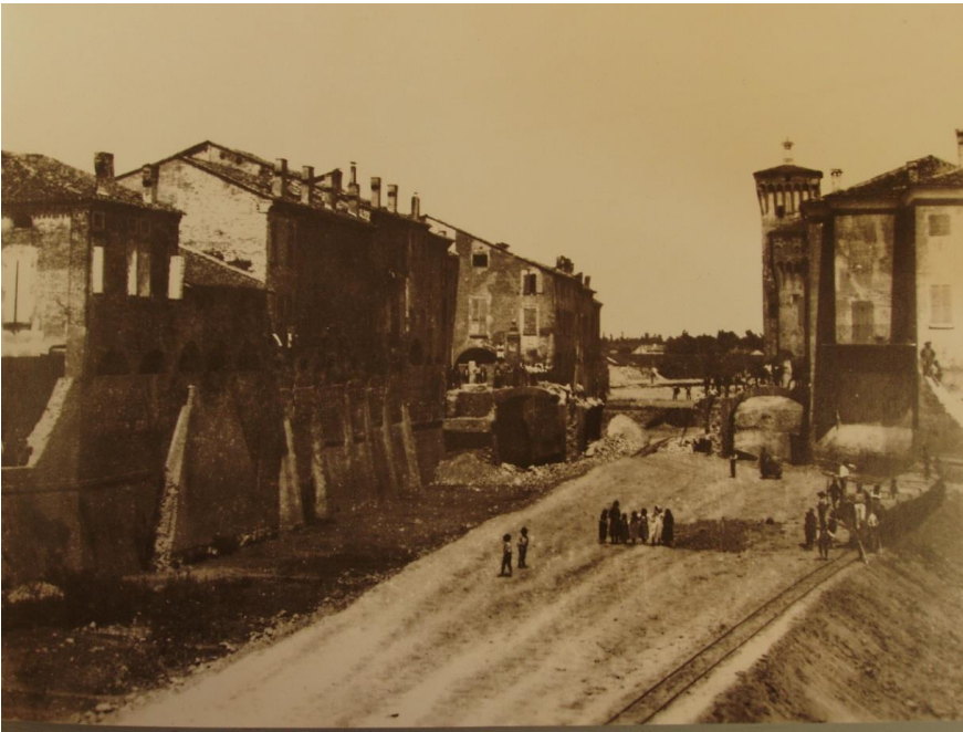
Fig. 38 – Fase di interramento del Panaro.
